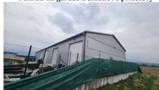
Pohľad na garáže a skladové priestory
