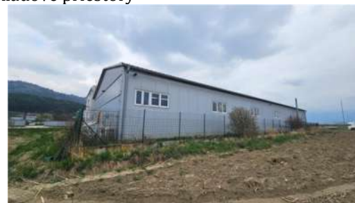
Pohľad na garáže a skladové priestory
